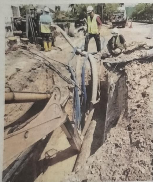
Kerja-kerja pembaikan paip utama di Persiaran Selangor, Seksyen 15 Shah Alam sedang giat dijalankan semalam.
